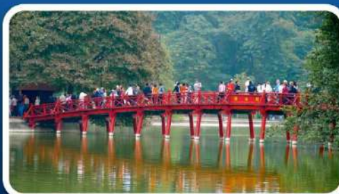
สะพานแสงอาทิตย์
