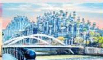
อาคารฟันทันไม
