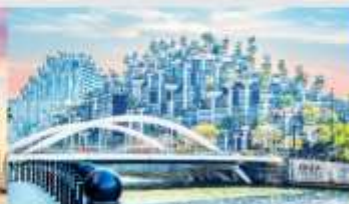
อาคารฟันทันไม
