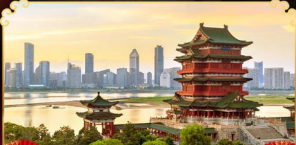
หอเกิงหวังเก้อ
